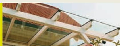
Bei allen Terrassendächern ist der Wandanschluss an das bestehende Gebäude nicht enthalten. Alle Fugen, insbesondere Wandanschlussfugen, sind Wartungsfugen. Um den konstruktiven Holzschutz der Balken zu gewährleisten empfehlen wir, neben einem deckenden Erstanstrich, eine Blechverwahrung und Dachrinne anzubringen.
